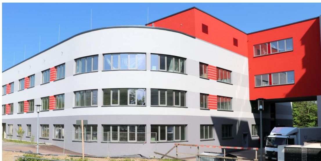
Ansicht des neuen Geriatrischen Zentrums am Harzklunikum Dorothea Christiane Erxleben in Quedlinburg; im Bild rechts der zweietagige Verbindungsgang in das Haupthaus. Foto: Tom Koch / Harzkllinikum
